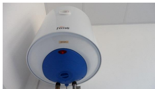
Figura 4.14 - Particolare di un boiler elettrico per la produzione di acqua calda sanitaria
