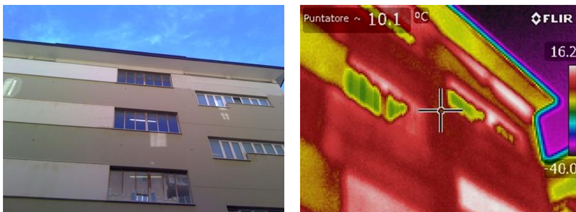
Figura 4.5 – Rilievo termografico dei serramenti
