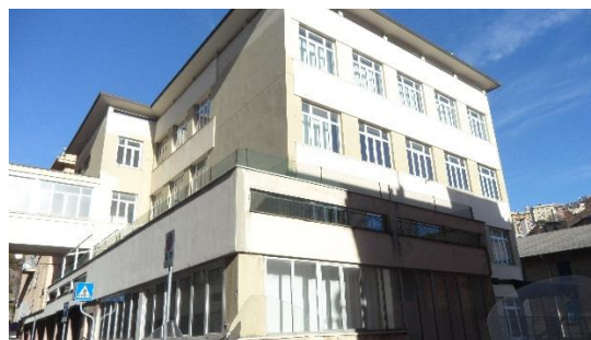
Figura 1.1 - Vista della facciata esposta a Sud.
