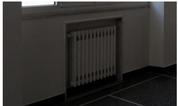
Figura 4.7 – Particolare dei radiatori in alluminio installati nella struttura
