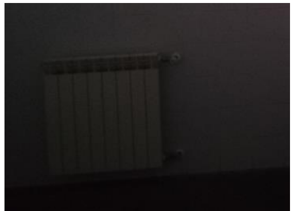
Figura 4.7 – Particolare dei radiatori in alluminio installati nella struttura
